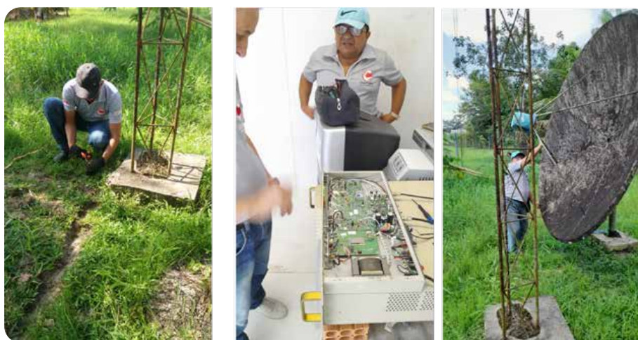
Manutenção corretiva no aterramento, alinhamento e na gaveta.
