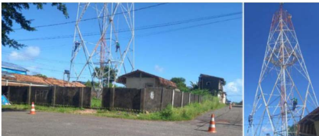
Figura 1 Manutenção corretiva na torre de Marapanim
